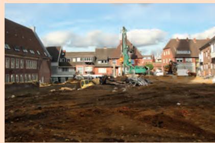
„Das IGZ entsteht“ Abrissarbeiten am Bült Oktober 2015
