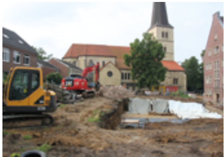
Blick auf die IGZ-Baustelle am Bült
