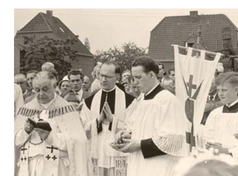
Pfarrdechant Dümpelmann beim ersten Spatenstich zum Bau der St. Josephs-Kirche
